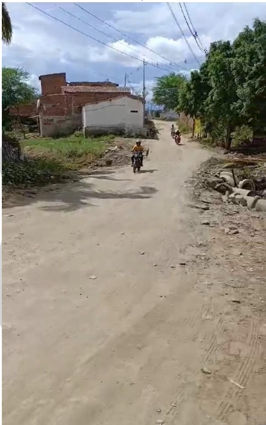
PASSAGEM MOLHADA DA RUA MANOEL MONTEIRO DA PAIXÃO BAIRRO MALAQUIAS
